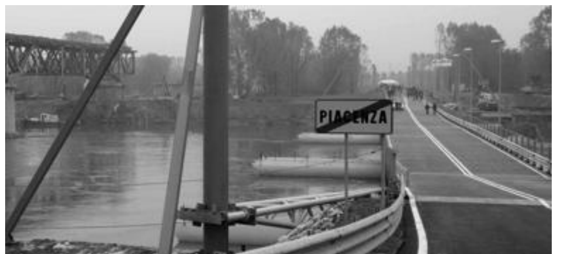
Il ponte di barche sul Po vietato ai ciclisti che non possono recarsi a Piacenza da quando il viadotto storico (a sinistra) è crollato
